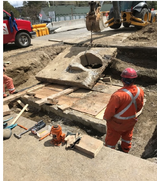
Exemple de réfection d'une chambre souterraine
