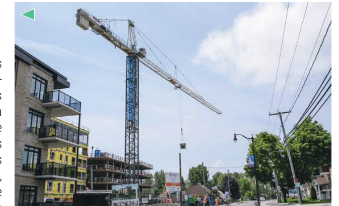
Chantiers Source : Ville de Saint-Eustache
