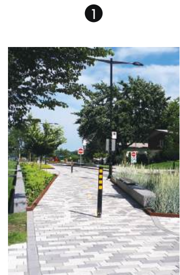
Réaménagement du domaine public entre le parc de l'Hôtel-de-Ville et Prince-Albert Source : Google Street View
