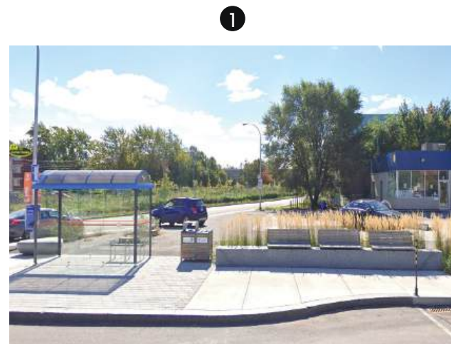
Réaménagement complet des arrêts d'autobus
