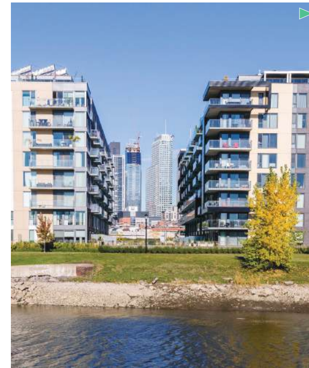
Bassin du Nouveau Havre, Montréal Source : Lemay
