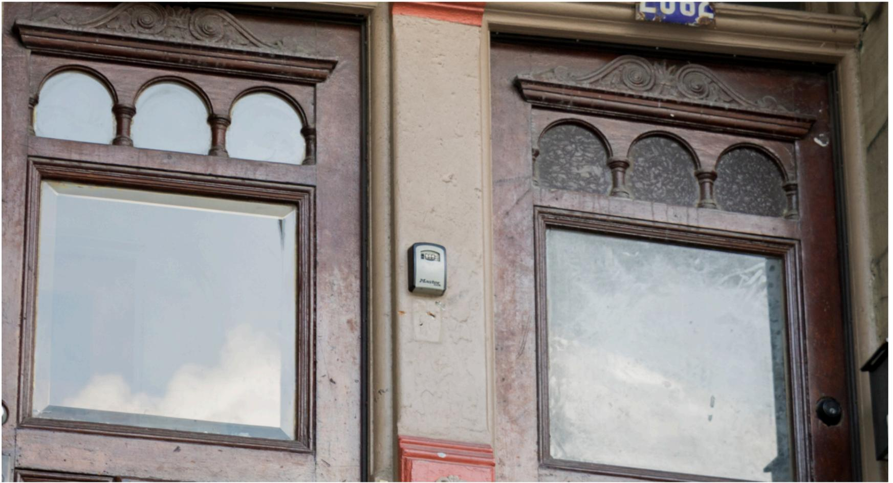
Châssis fixe ou mobile, généralement vitré, situé au-dessus d'une porte ou d'une fenêtre et séparée de celle-ci par une traverse.
