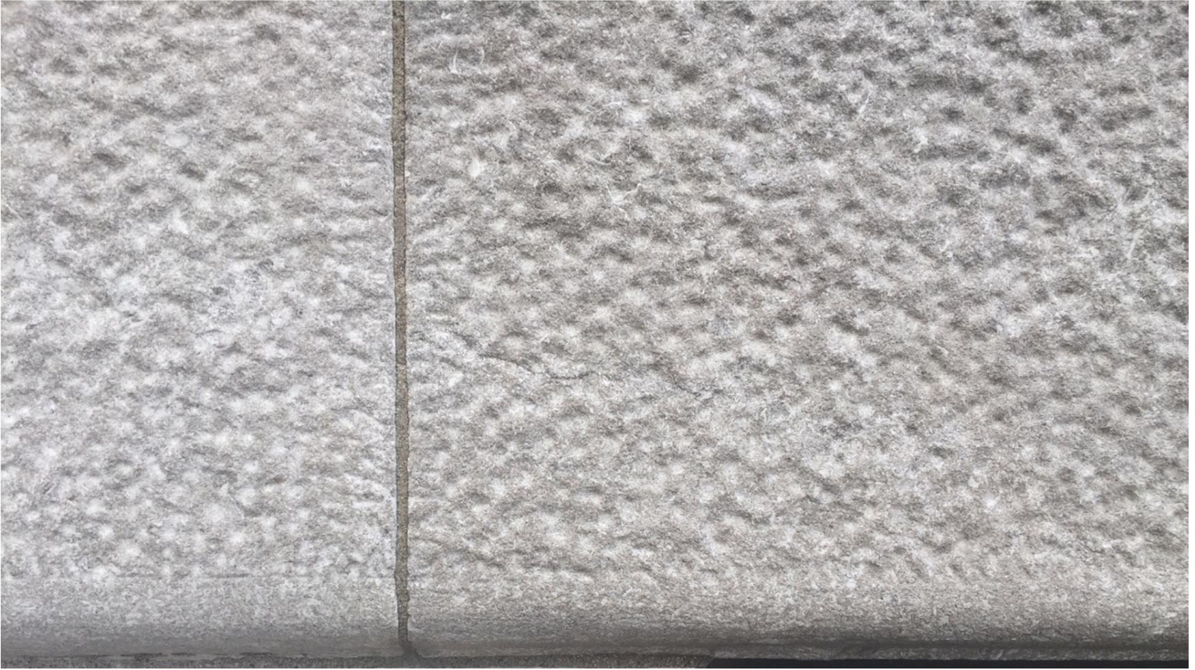
Technique de traitement du parement créant un motif de points réguliers, exécutée à l'aide d'un marteau « boucharde ». Peut être réalisée à des fins esthétiques ou utilitaires en rendant la surface antidérapante.
