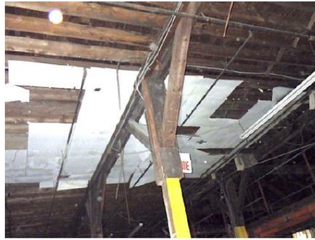
Plafond 1 er niveau : poutre et solive, amiante
