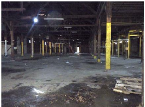
Vue générale vers l'avant
